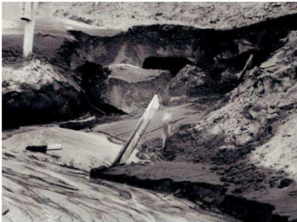
Рисунок 2 – Термофильтрационная эрозия низового откоса намывной дамбы хвостохранилища № 1 Норильского ГМК
