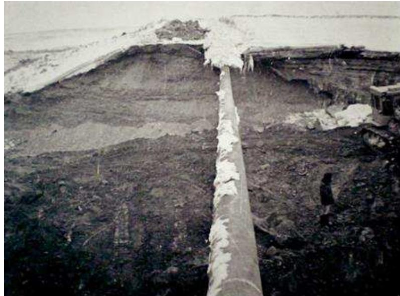
Рисунок 5 – Разрушение ограждающей дамбы золоотвала № 1 Абаканской ТЭЦ (поперечное сечение дамбы в проране)
