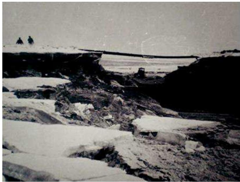
Рисунок 6 – Разрушение ограждающей дамбы золоотвала № 1 Абаканской ТЭЦ (вид из вытекшей емкости)
