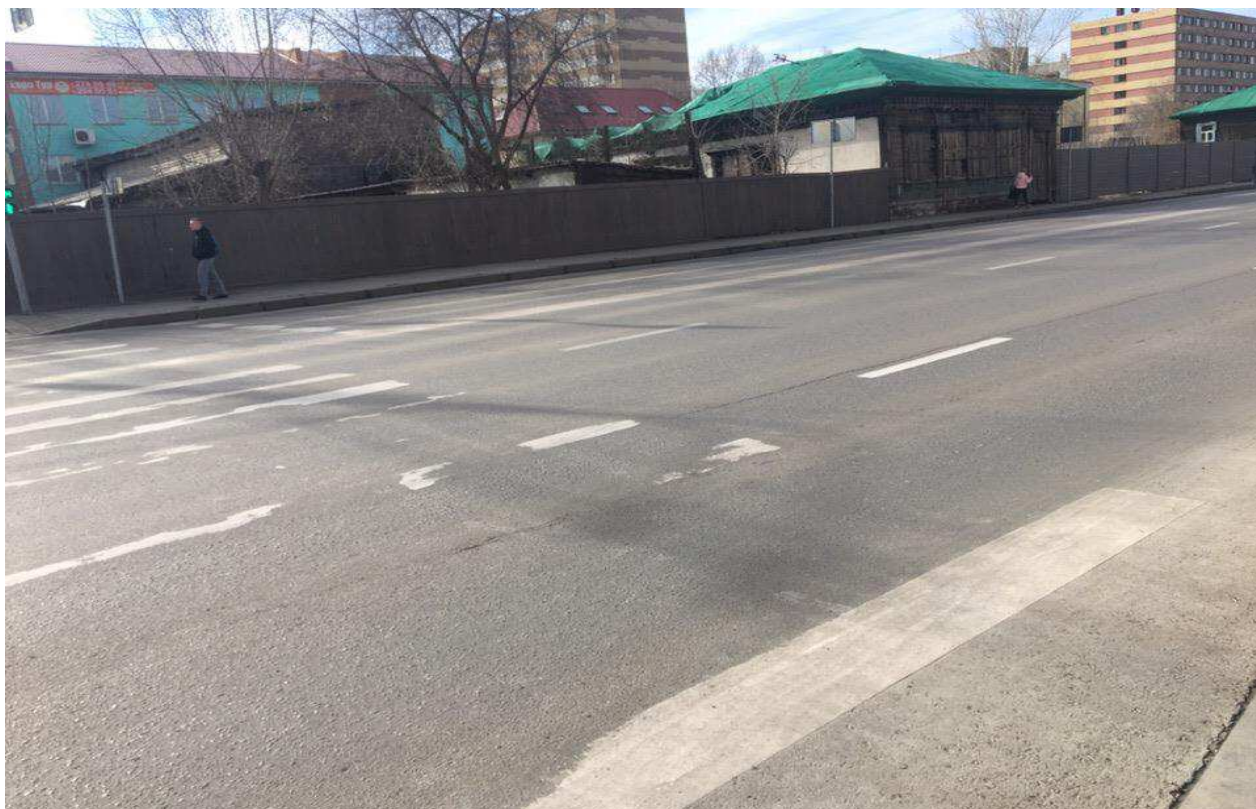
Рисунок 1.2 – Графическое изображение износа разметки на пешеходном переходе
