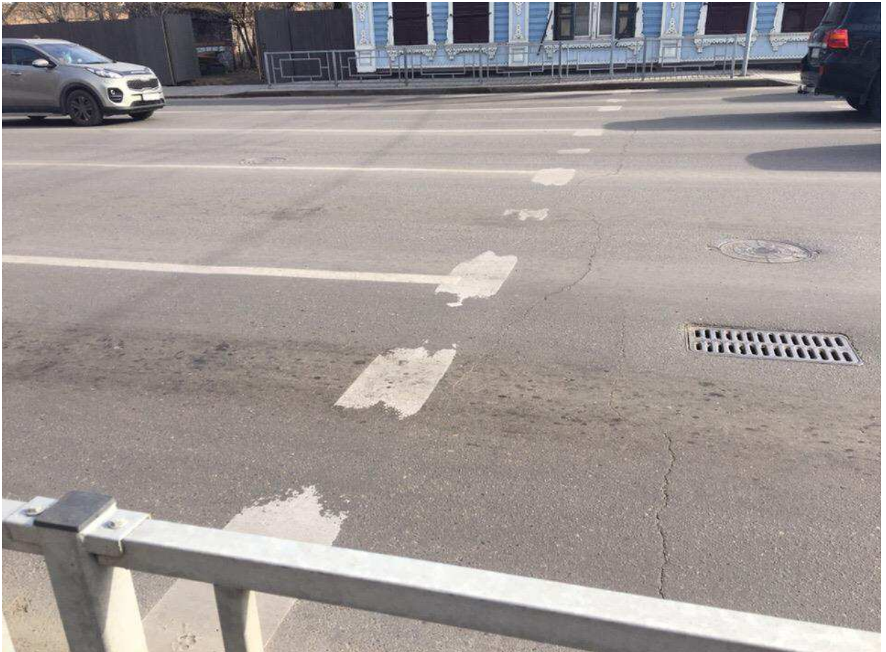
Рисунок 1.3 – Графическое изображение износа разметки 1.12 (стоп-линия)
