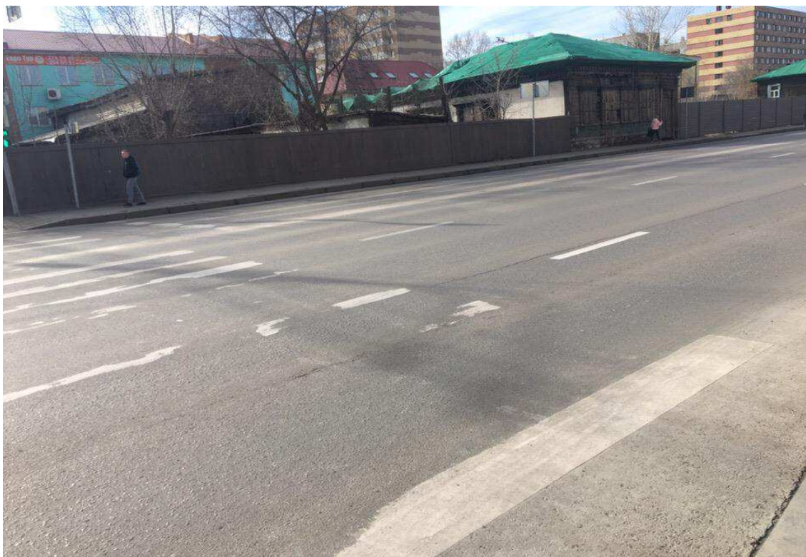
Рисунок 1.5 – Графическое изображение износа разметки на пешеходном переходе.
