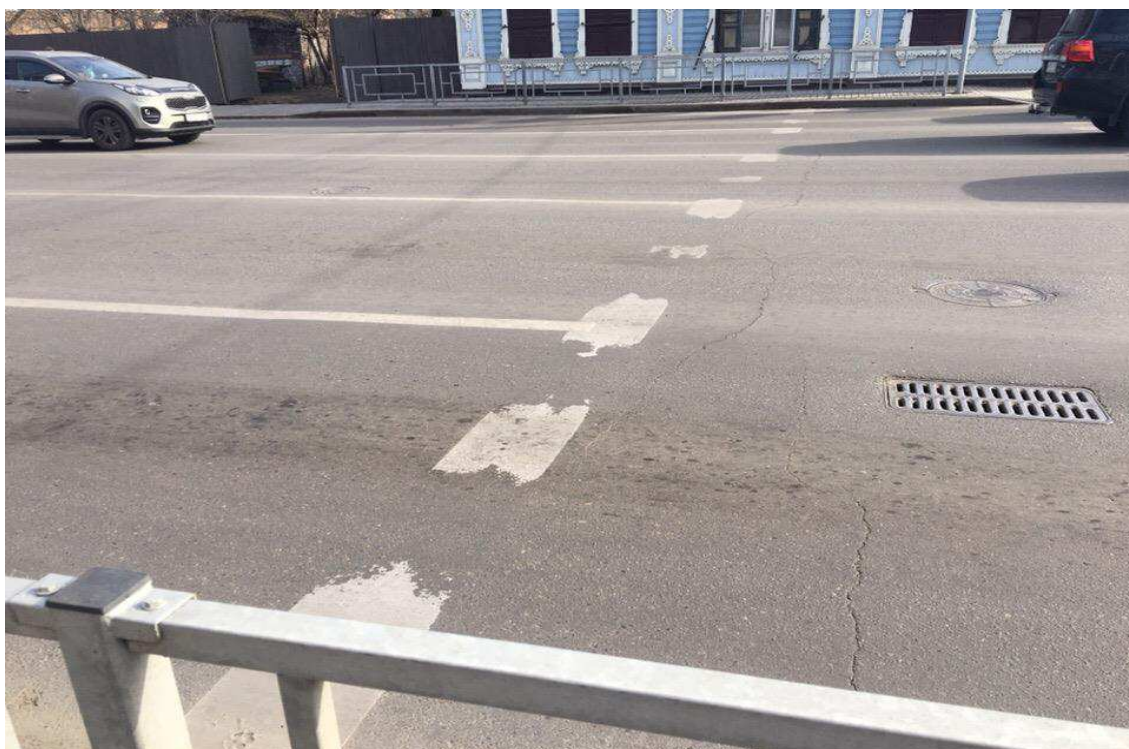
Рисунок 1.6 – Графическое изображение износа разметки 1.12 (стоп линия).
