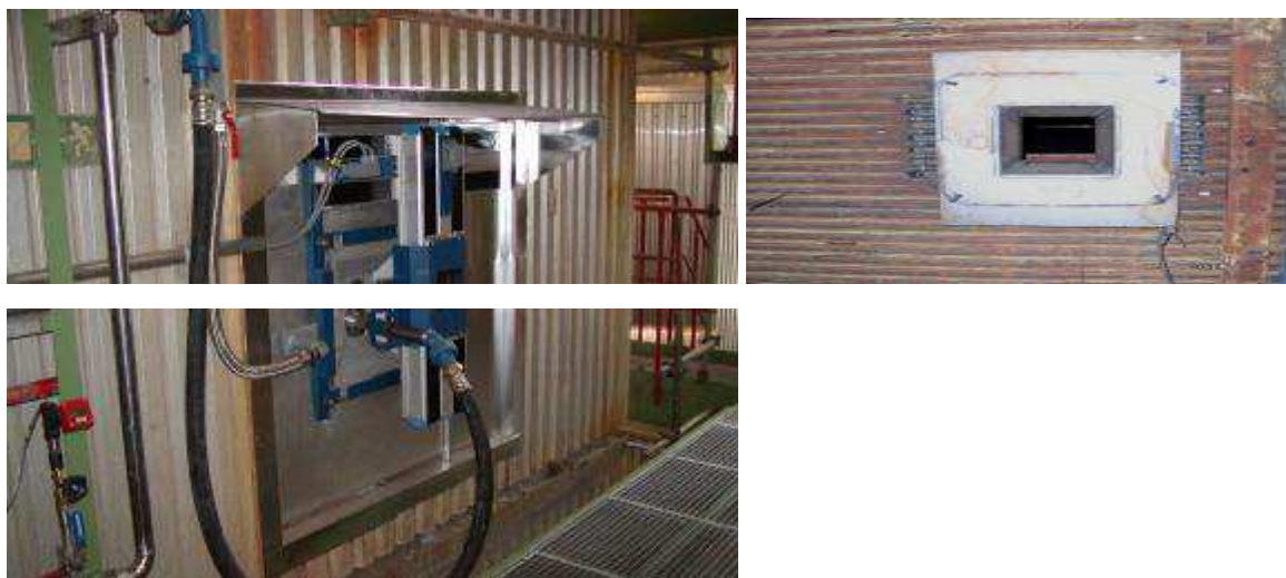
Рисунок 1.7 – Аппарат типа WLB на котле и вид на амбразуру аппарата из топки
