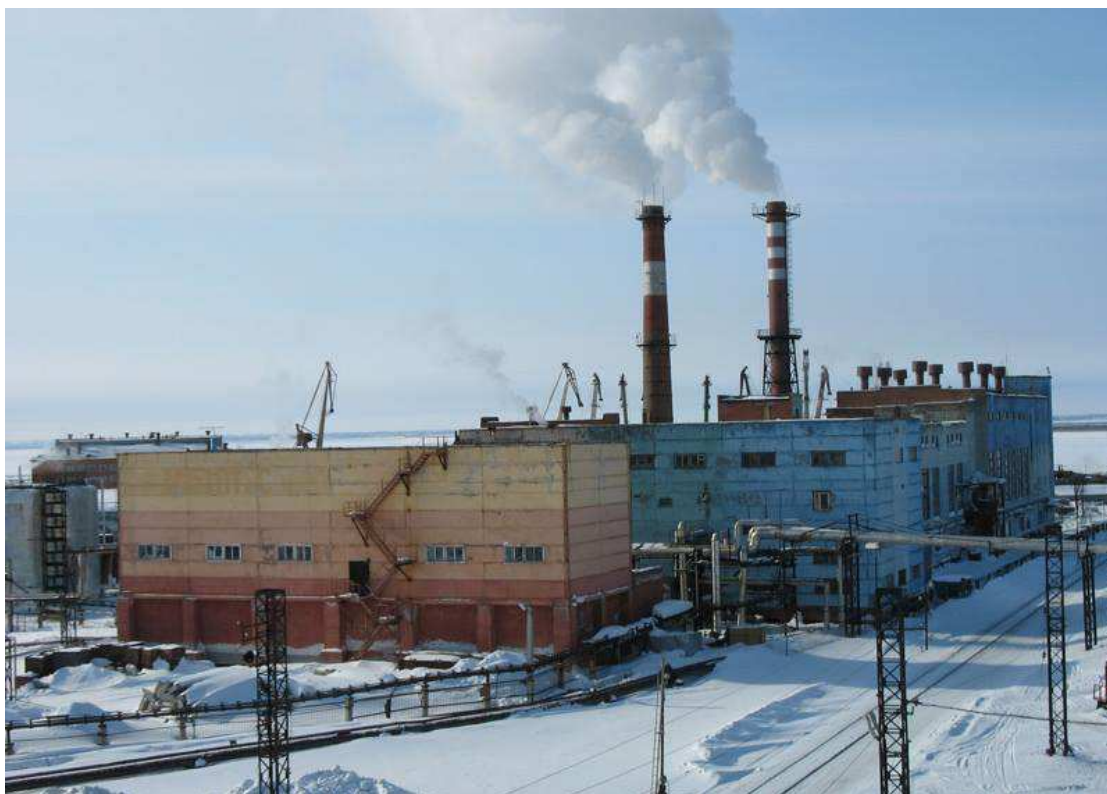
Рисунок 1.1 – Котельная №7 в г. Дудинка
