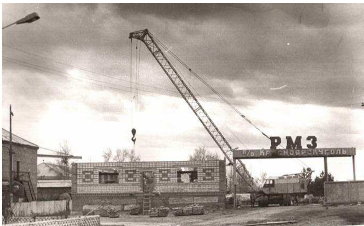
Рисунок 1.1 – Строительство «Черногорский РМЗ»
