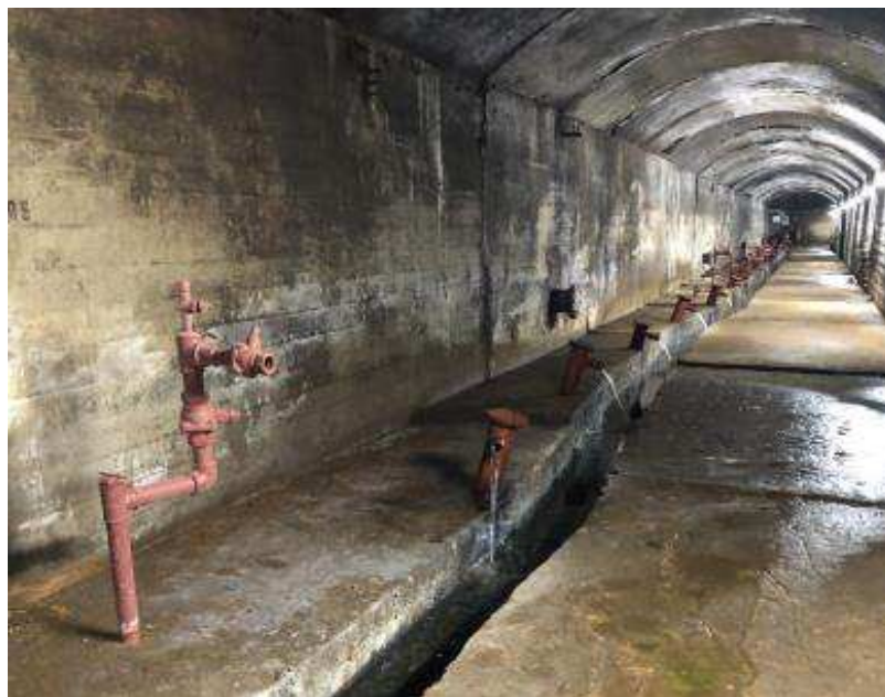
Рисунок 7 – Пьезометр и дренажные скважины
