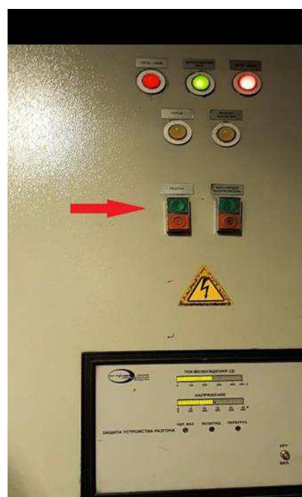
Рисунок 2.11.3 – Включение кнопки «Разгон»
