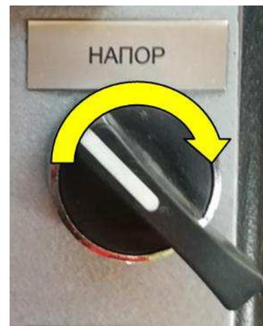
Рисунок 2.11.18 - включение напора ключом
