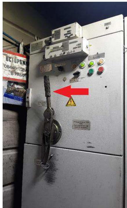
**Рисунок 2.11.1 - Перевод высоковольтного разъединителя в рабочее положение**
