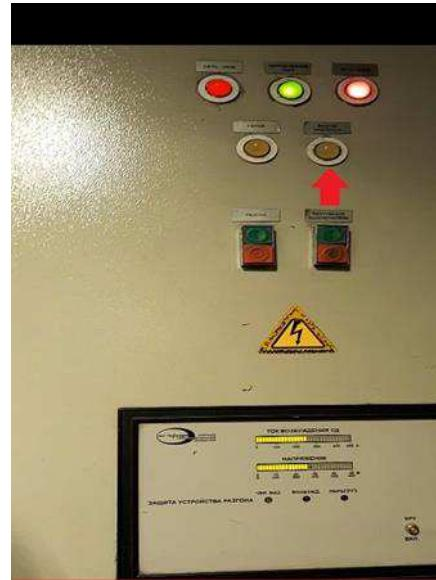
Рисунок 2.11.4 – Загорание лампочки «Разгон закончен»
