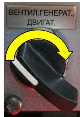
Рисунок 2.11.15 - включение вентиляторов генераторов двигателя ключом
