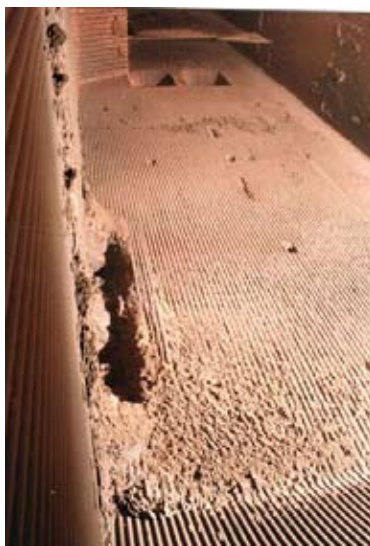
Рис. 3. Участки топочных экранов до и после водяной очистки
