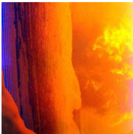
Рис. 1. Шлак в зоне горелок после длительной эксплуатации
