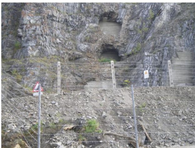
Рис. 2. Положение рудной зоны с урановым оруденением в скальном уступе доломитизированных известняков на участке «Согренский» (осень 2006 г). Ниже – состояние (сентябрь 2010 г) после выполнения защитных мероприятий ООО «Квант», г. Красноярск
