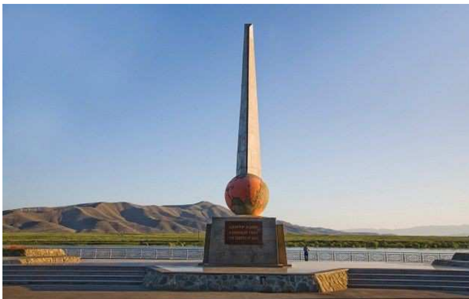
Рисунок Б.1 – обелиск «Центр Азии» до реконструкции
