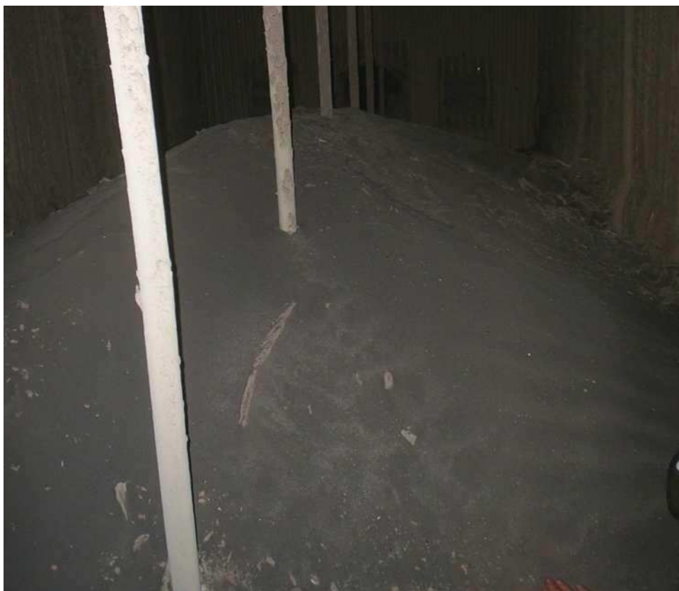
Рисунок 1.4 - Золовые отложения на поверхности конвективного пароперегревателя
