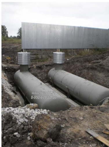
Рисунок 7.2 – Установка резервуаров на фундамент
