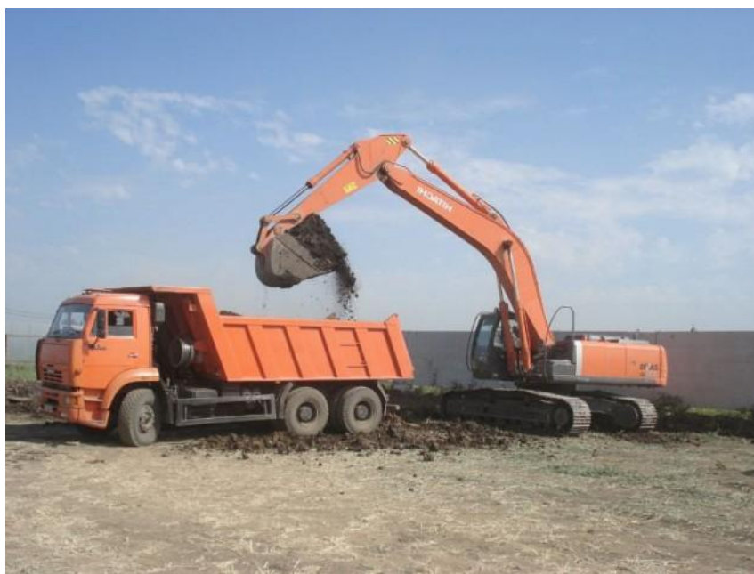
Рисунок 7.1 – Рытье траншеи под газопровод экскаватором
