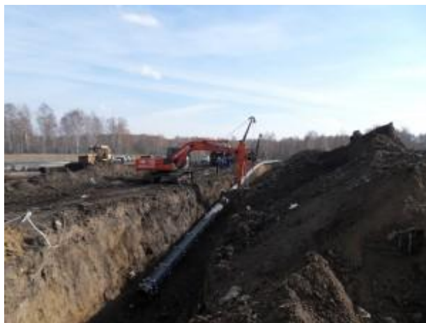
Рисунок 7.3 – Укладка газопровода
