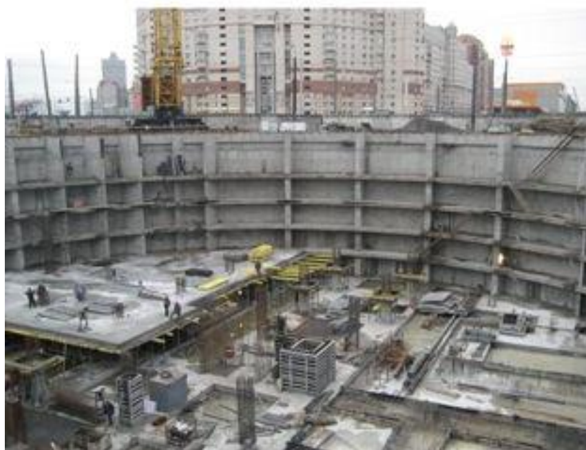
Рисунок 1.1.2 - Строительство подземного пятиуровневого сооружения на Коменданской площади в г. Санкт-Петербурге.
