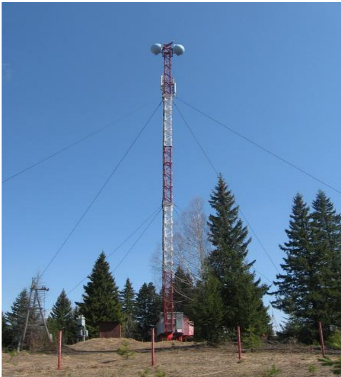
Рисунок 1.10– Ферменное антенно-мачтовое сооружение.
