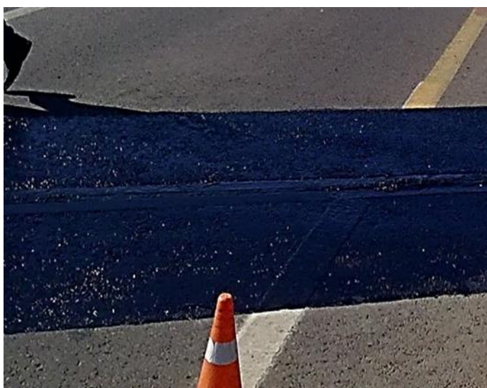
Рисунок 8 – Пропитка асфальтобетонная «Элмодор».
