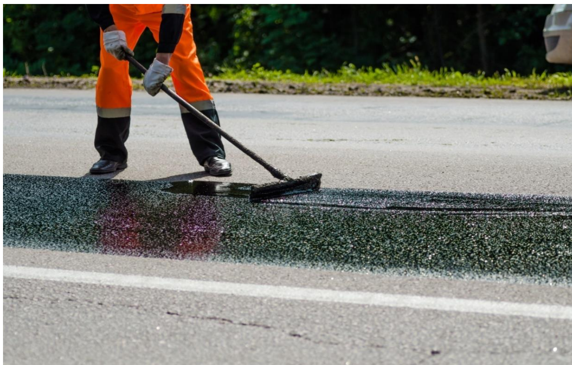
Рисунок 12 – Распределение пропиточного состава вручную
