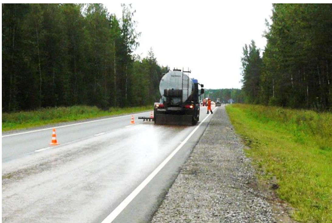
Рисунок 10 – Нанесение пропиточного состава с помощью автогудронатора
