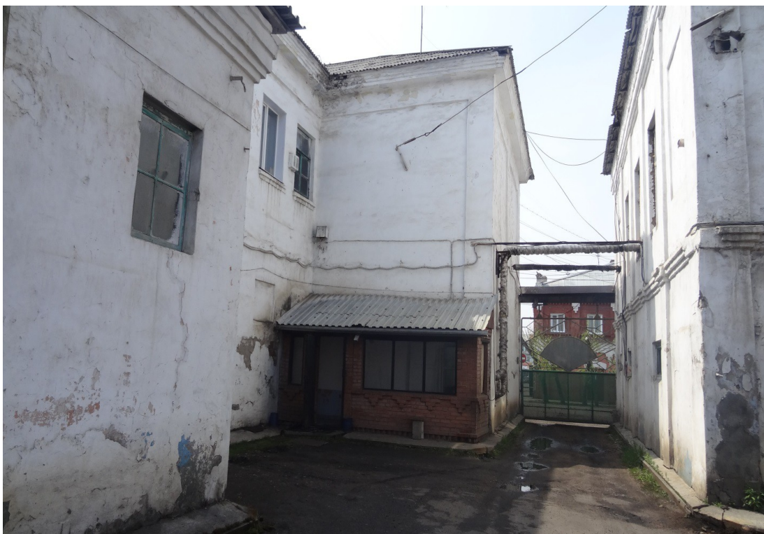
Рисунок 4 – Общий вид здания (задний фасад)
