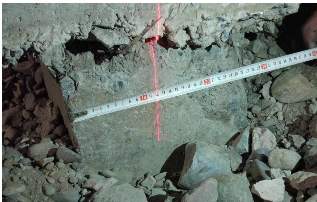
**Рисунок 1.18 – Фиксирование значений смещения сваи относительно оси 10 составило 3 см**
