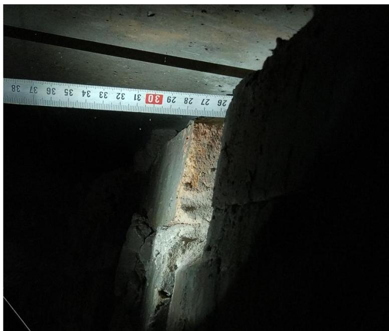
Рисунок 1.13 – Опирание плиты перекрытия на стену составляет 28 см
