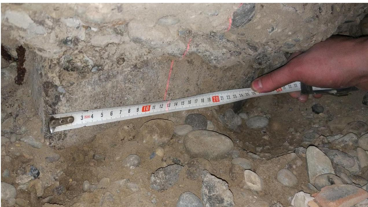
**Рисунок 1.21– Фиксация значений смещения сваи относительно оси 10 составило 2.2 см**
