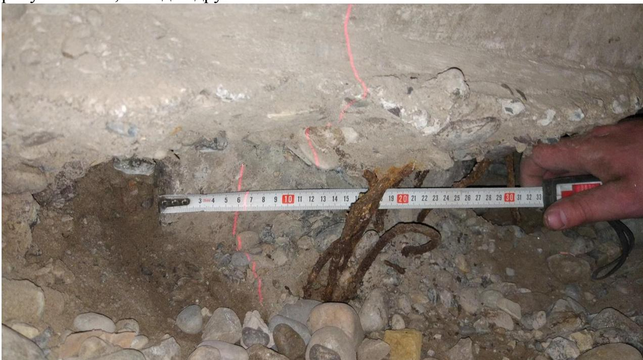
**Рисунок 1.20 – Фиксация значений смещения сваи относительно оси Д составило 8.5 см**
