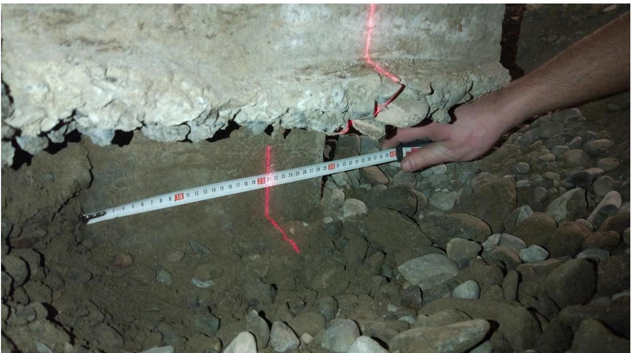
**Рисунок 1.23 – Фиксация значений смещения сваи относительно оси 10 составило 6.2 см**
