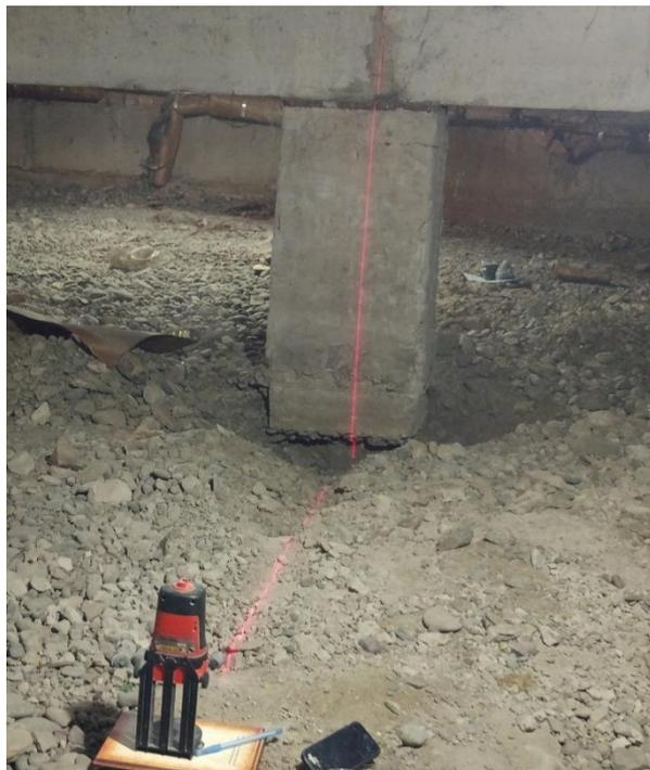
Рисунок 1.14 – Лазерный уровень установлен относительно центра оси Г
