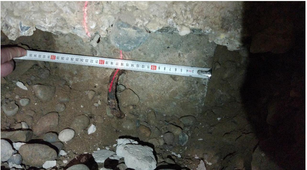
**Рисунок 1.22 – Фиксация значений смещения сваи относительно оси Е составило 1.5 см**
