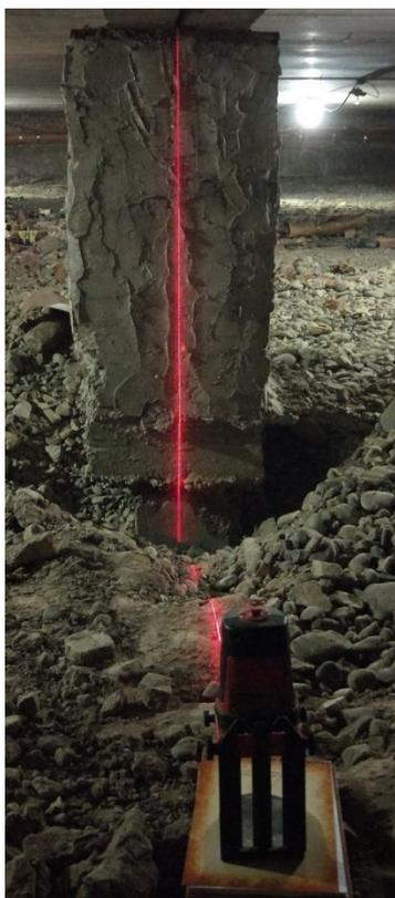
**Рисунок 1.17 – Лазерный уровень установлен относительно центра оси 10**
