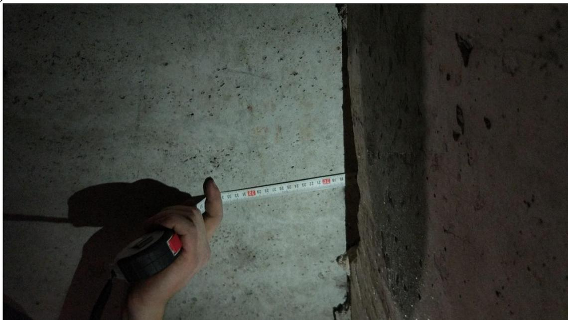
Рисунок 1.12 – Опирание плиты перекрытия на ригель составляет 17.5 см
