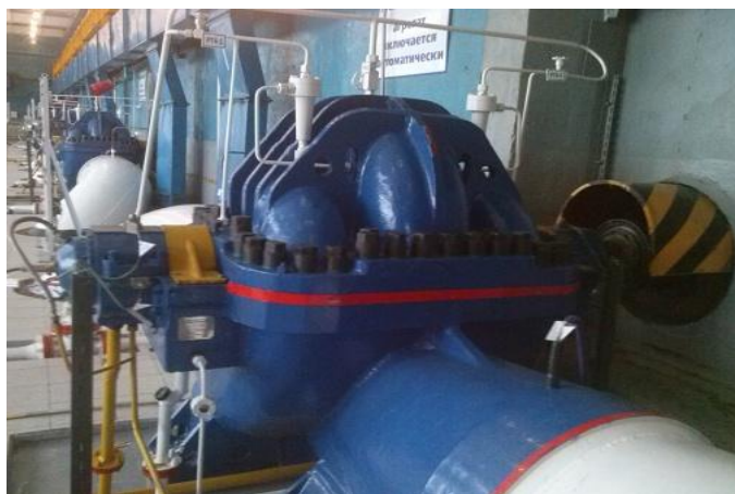
Рисунок 2 – Традиционная система разгрузки и охлаждения концевых уплотнений вала насоса
