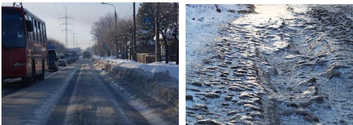
Рис. 1. Снежно-ледяные образования на дорогах города Красноярска: а – колея, б – обочина.
