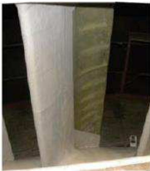
Рисунок 36 – наплавка из композитного материала
