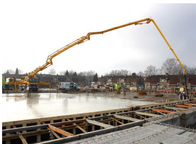
Рисунок 4.16 – Работа автобетононасоса SCHWING 34X
