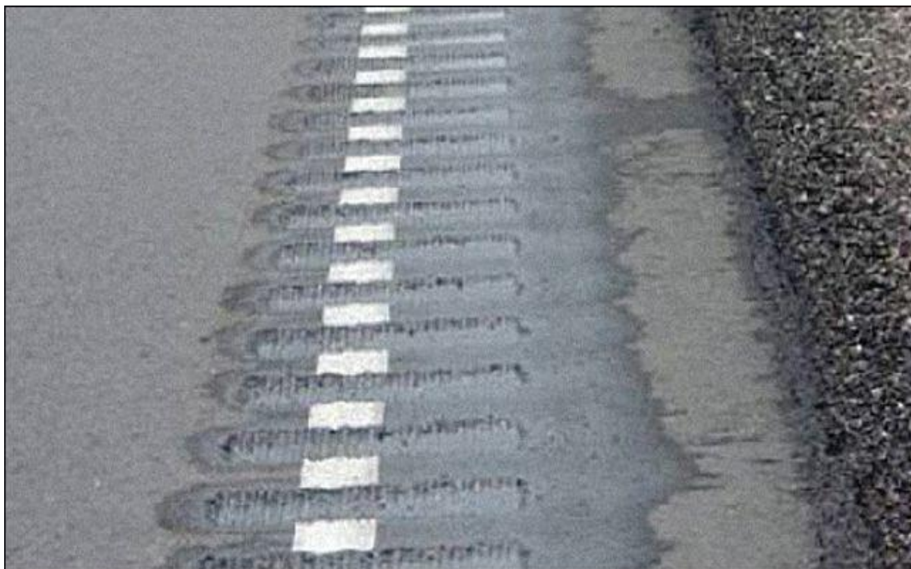
Рисунок 9.2 – Шумовые полосы вдоль края проезжей части
