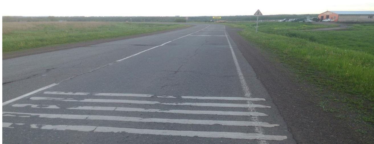
Рисунок 9.1 – устройство шумовых полос на опасных участках КМ 386+450
