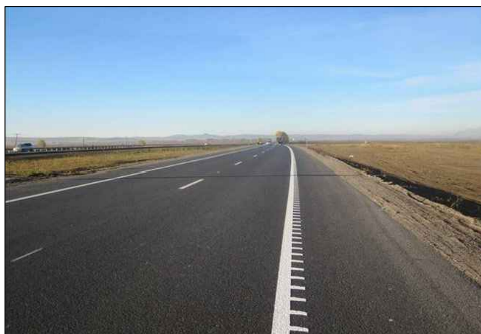
Рисунок 2 - На клееные шумовые полосы вдоль краевой полосы
