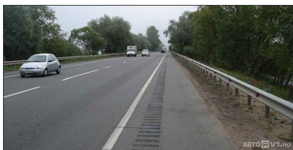
Рисунок 1 - Шумовые полосы устроенные методом фрезерования
