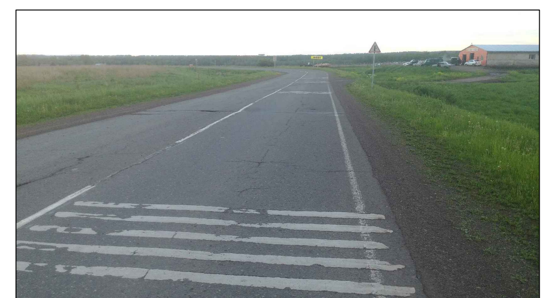
Рисунок 3 - Шумовые полосы перед опасным участком на КМ 386+450
