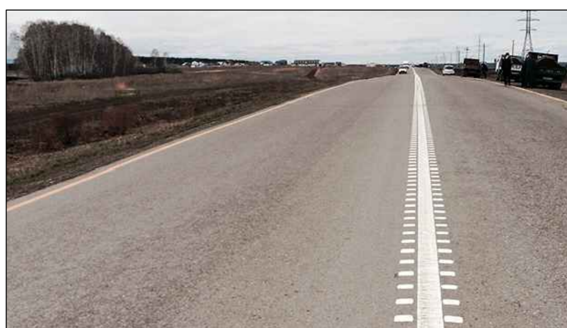
Рисунок 3 - Шумовые полосы вдоль оси проезжей части
