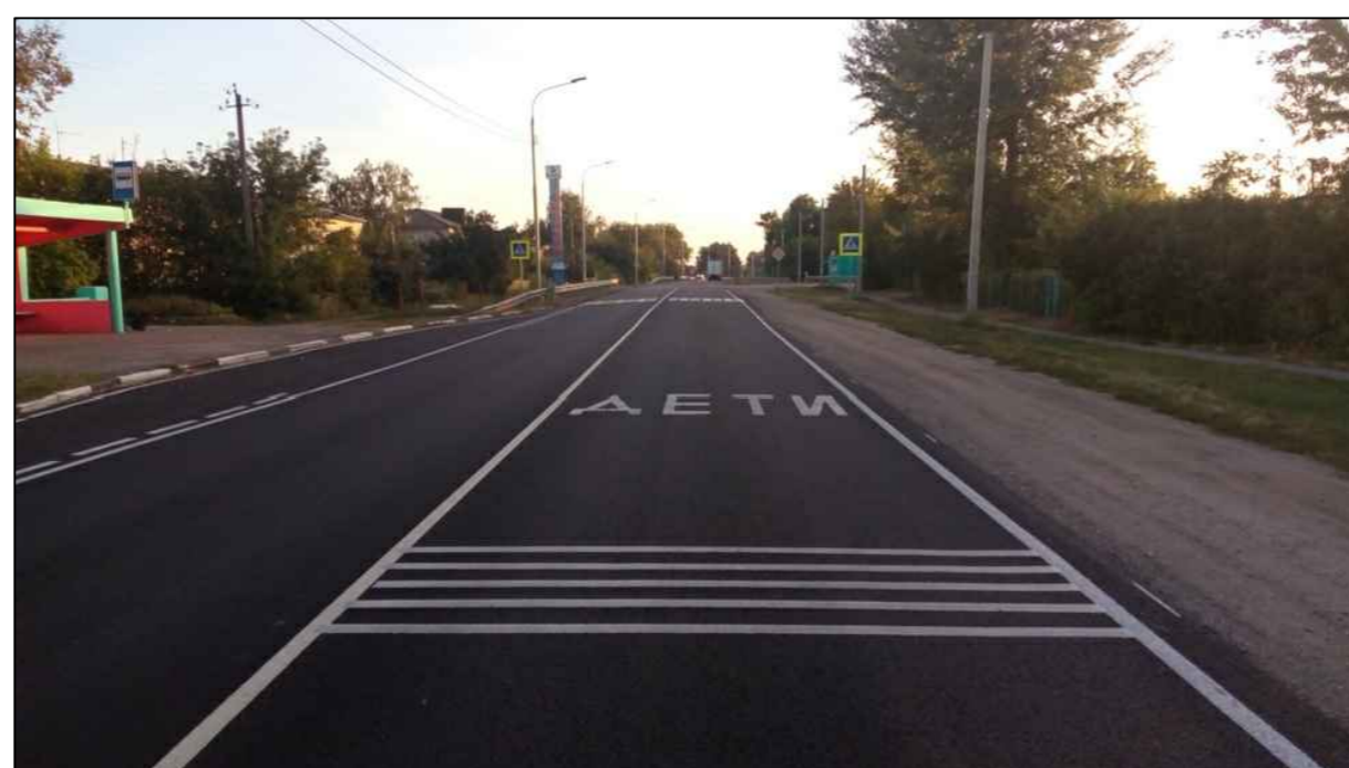
Рисунок 4 - Шумовые полосы перед пешеходным переходом
