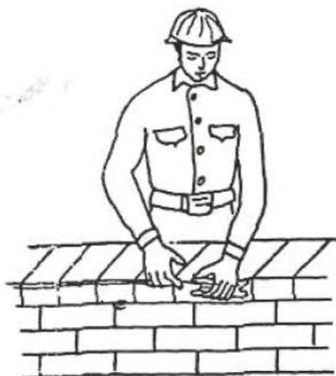
Рисунок 6.8 – Натягивание причального шнура на уровне верха укладываемых кирпичей
