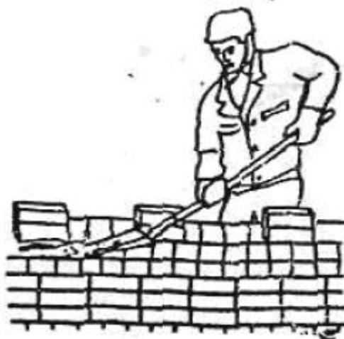
Рисунок 6.12 - Раскладка раствора для наружной версты ложкового ряда
