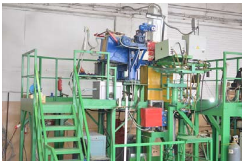
Рис. 1. Плавильно-литейный комплекс с электромагнитным кристаллизатором
