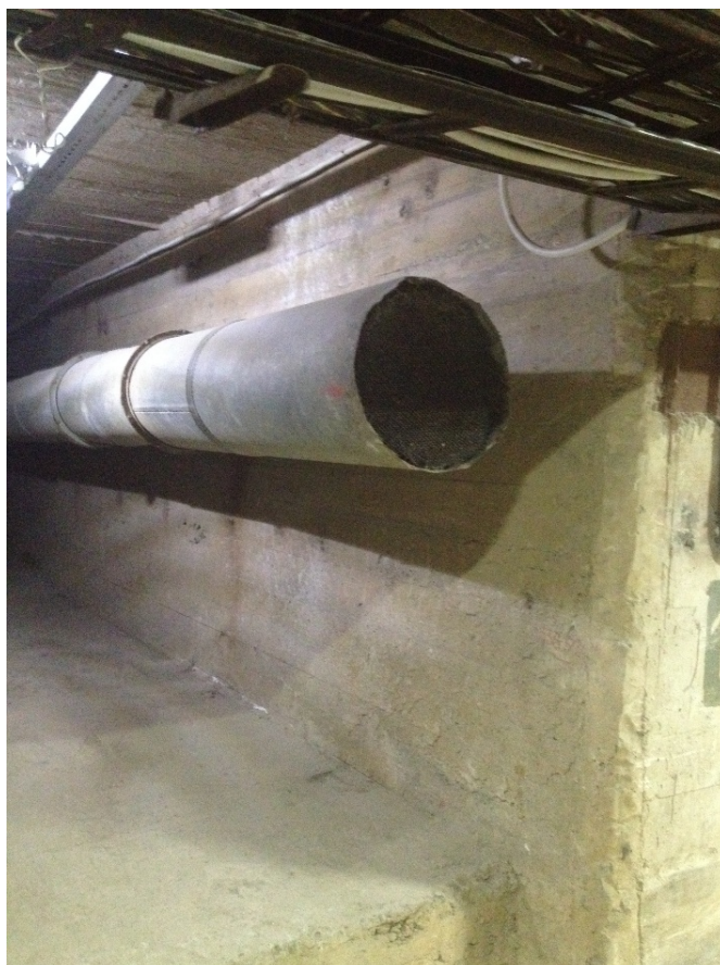
Рисунок 8.5 – Вентиляция воздуха с подогревом электрокалорифером
