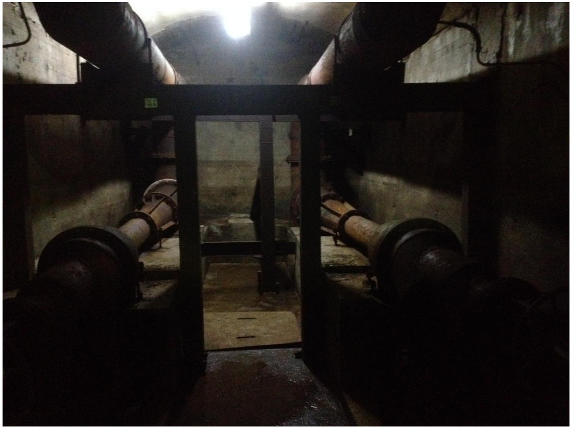
Рисунок 8.8 – Эжекторная насосная установка
