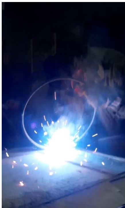
Рисунок 25– Сварка прута для подставки
