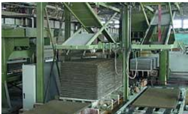
Рисунок 5 - Процесс формирования непрерывной трёхслойной ЦСП-плиты
