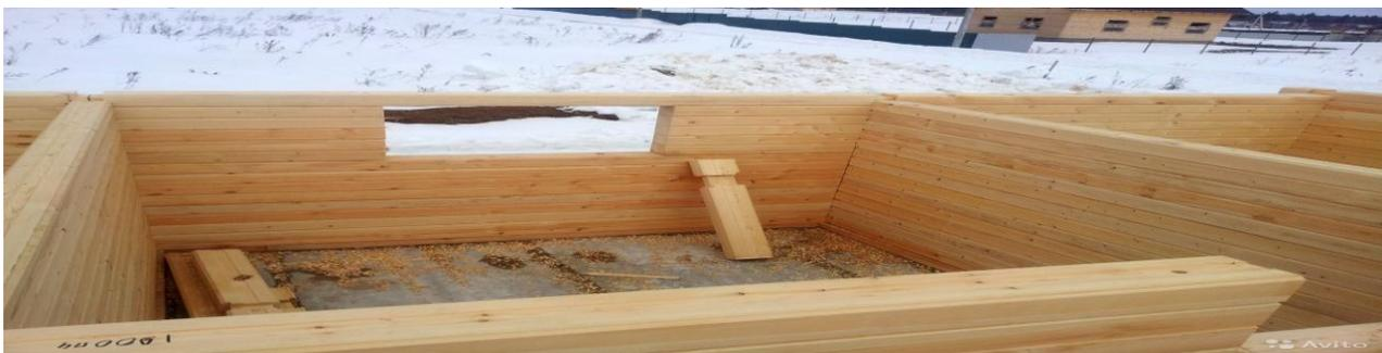
Рисунок 5 – Возведение наружных и внутренних стен из клееного бруса
