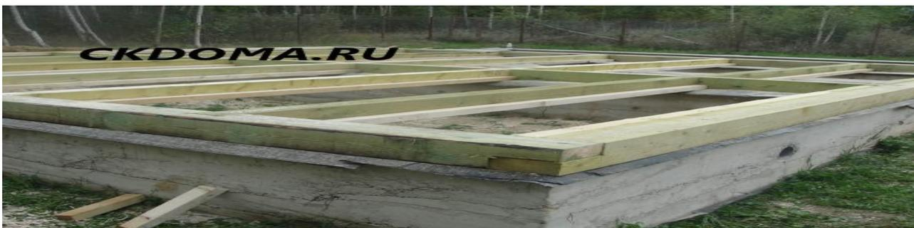
Рисунок 3– Обвязка брусом фундамента
