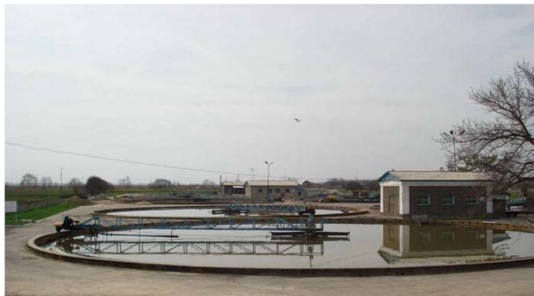
Рис2 – Радиальная нефтеловушка
