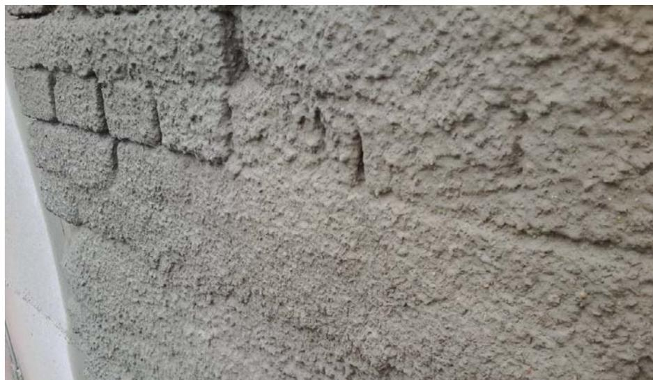
**Рис.2- Фактура поверхности торкрет-бетона с применением дробленого песка**
