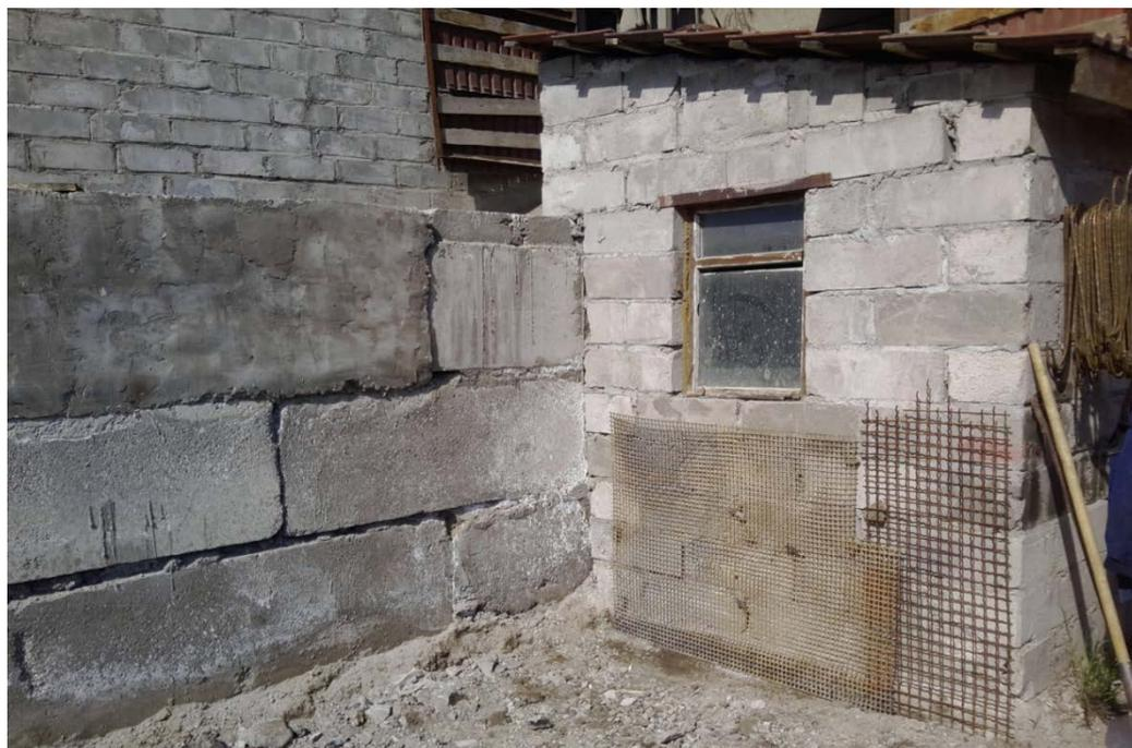
***Рис.1 - Подготовка поверхности, зачистка, анкеровка металлических сеток, обеспыливание***
