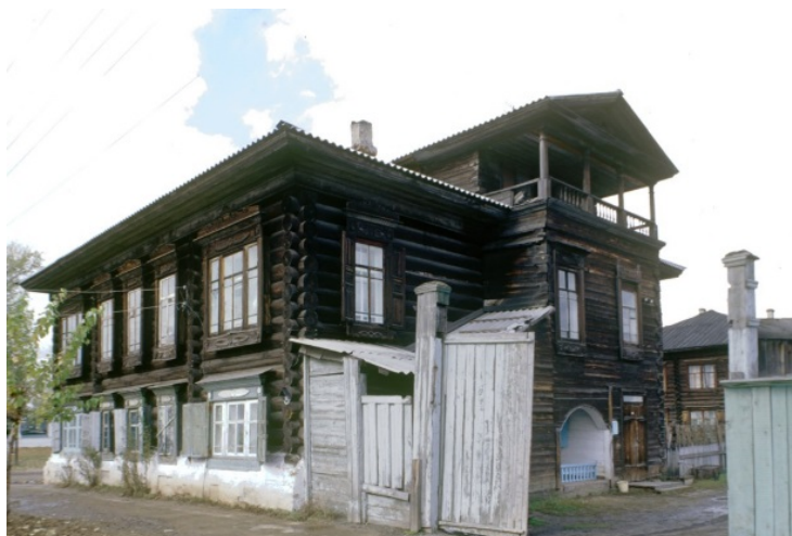
Рис.2 - Енисейск. Жилой дом по ул. Рабоче-Крестьянская, 114
