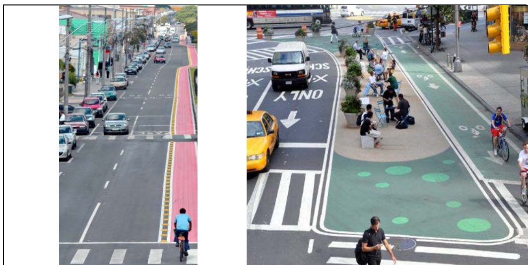
Рис.1 – Использование цветных асфальтовых покрытий в дорожной разметке и для выделения велосипедных дорожек (США)
