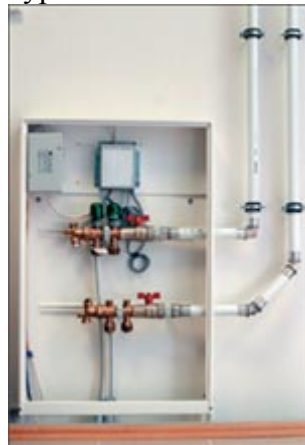
Рис. 4. Узел смешения тёплого пола
