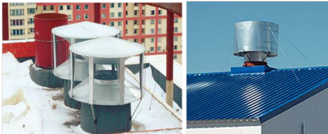
Рисунок 1. Дефлекторы АСТАТО и дефлектор ЦАГИ
