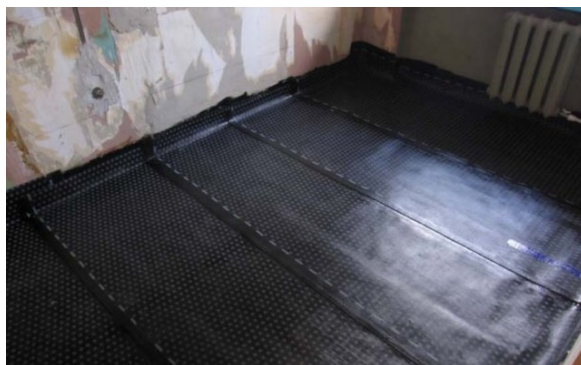
Рис. 2.. Гидроизоляция перед укладкой контуров теплого пола
