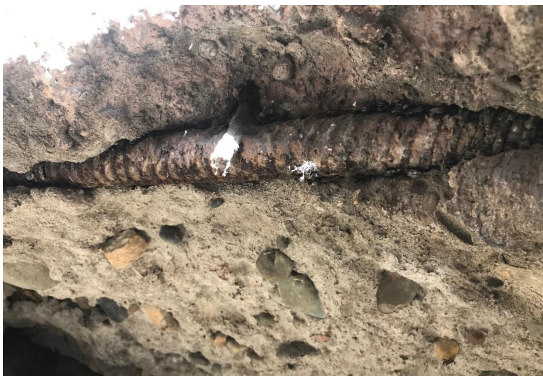
Рисунок 3.3 – Совместно с рис. 3.1-3.2; вид ростверка снизу: оголена рабочая арматура
