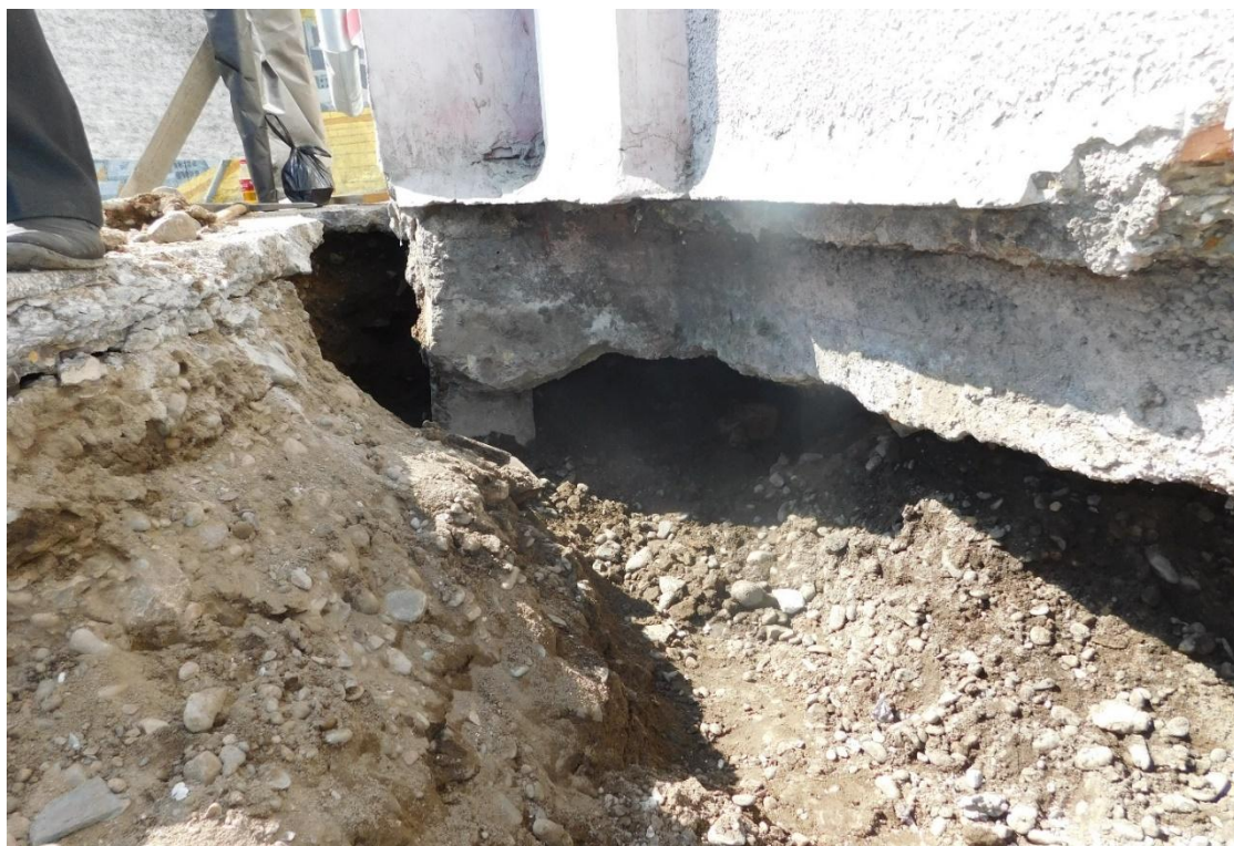
Рисунок 3.1 – Для исследования фундаментов выкопаны шурфы, освидетельствованы сваи и ростверк (на снимке шурф в осях 3-Е)
