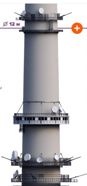
Рисунок А.3 — Устройство Останкинской башни агентства ТАСС
