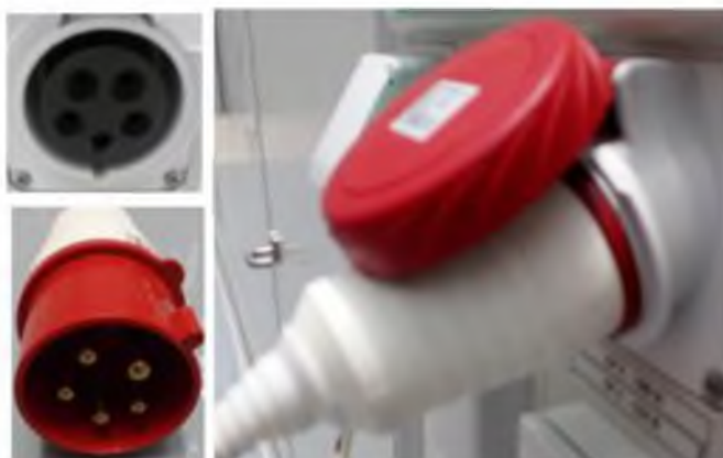
Рисунок 20 – Вилка и розетка питания шкафа управления, подключение вилки питания шкафа управления к стационарной розетке
