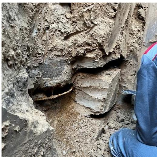
Рисунок 38 – Отбор монолита, в месте окончания фундамента
