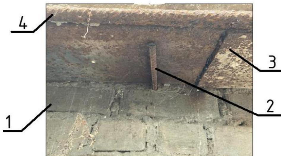
1 - кирпичная кладка; 2 - анкер; 3 - уголок 100x100; 4 - дополнительные два стержня  $\varnothing$  14 мм за уголком к наружному цоколю здания (выполнено по всему периметру объекта)
