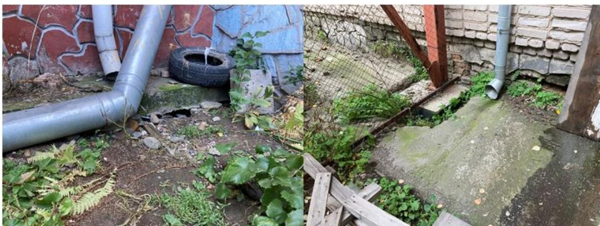
Рисунок 39 – Сброс воды с кровли под отмостку
