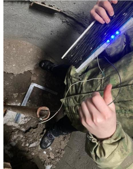
**Рис. 2.** Пьезометрическая скважина в наблюдательном колодце: *a* - Конструкция наблюдательного колодца: 1 – ж/б колодец, 2 – приямок из стальной трубы, 3 – пьезометрическая скважина; *b* - производство замеров
