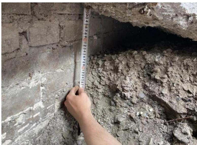
Рисунок 30 – Освидетельствование пустоты под отступкой и строительного мусора
