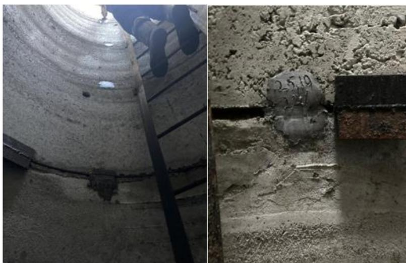
Рисунок 6 - Система марок на швах колец
