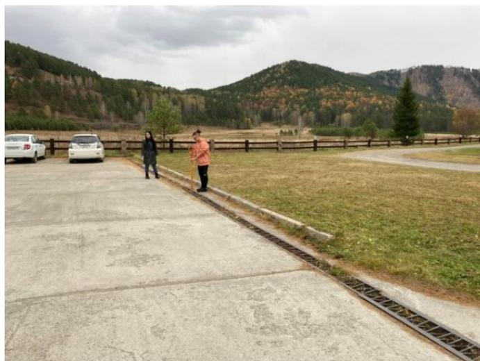
Рисунок 19 - водоотводной лоток в нижней части парковки
