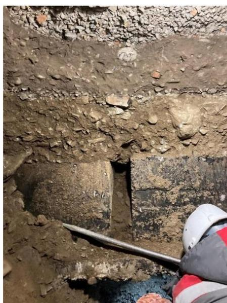
Рисунок 25 – Отбор грунтов под подошвой фундаментов в осях «Б»; «В» - «3»
