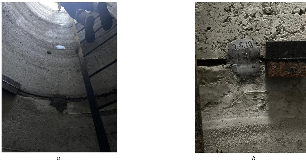
**Рис. 4.** Система марок на швах колец в наблюдательном колодце: *a* – система марок, *b* – одиночная марка
