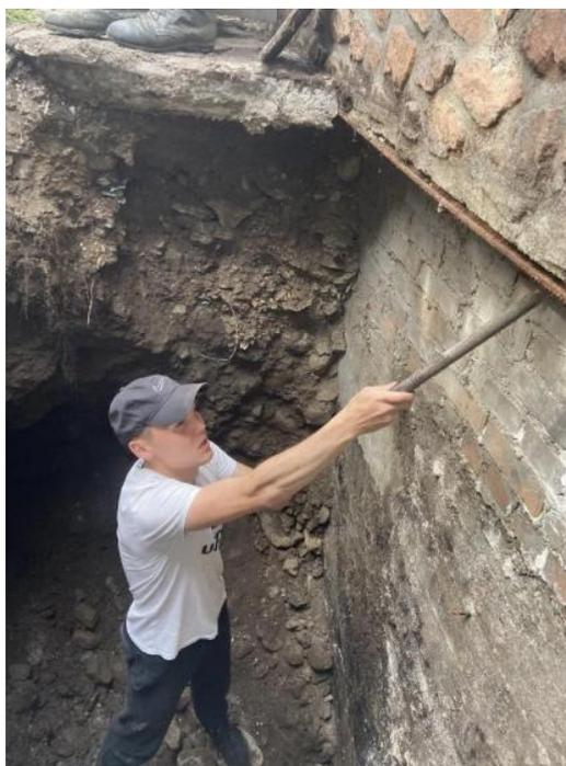
Рисунок 29 – Освидетельствование консольного выступа в шурфе №4
