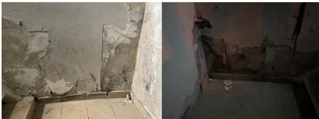
Рисунок 15 - Ускоренная деструкция бокового входа в подвал
