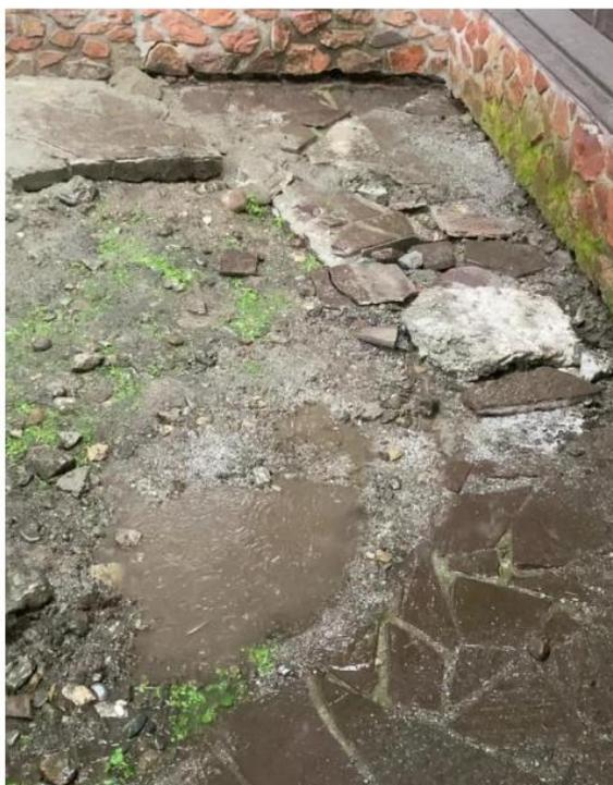
Рисунок 32 – Образование луж в период дождя слева от главного вход
