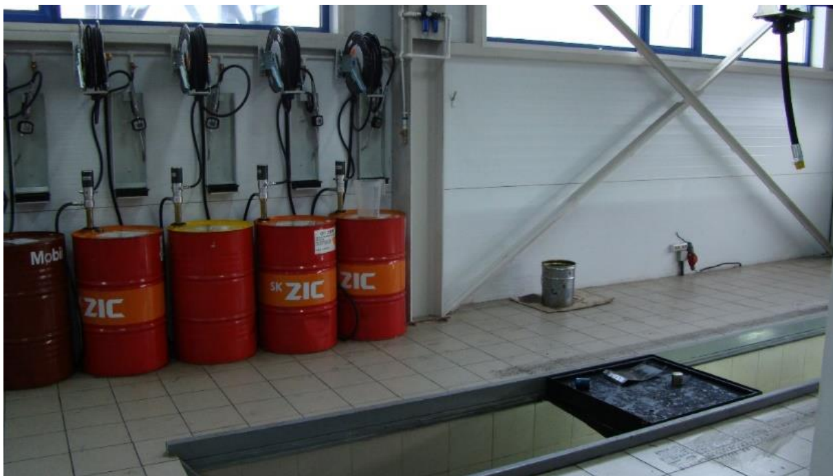
Рисунок 1.4 – Пост замены эксплуатационных жидкостей
