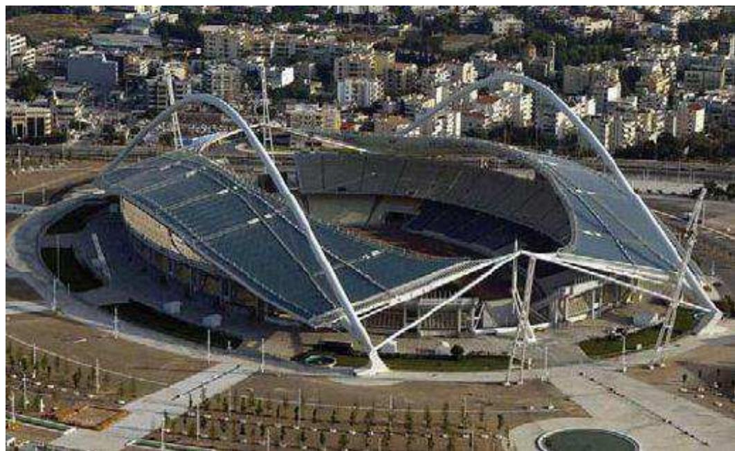
Рисунок 1.7 - Стадион «Спирос Луис», висячее вантовое покрытие, Афины
