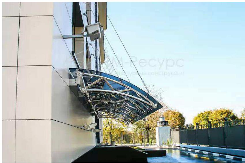
Рисунок 1.8 – Козырек консольно-вантового типа длиной 6,5 м
