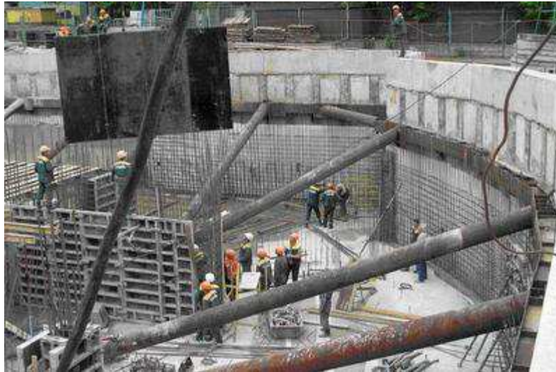
Рисунок 1.1.1 - Строительство подземного пятиуровневого сооружения методом «стена в грунте»
