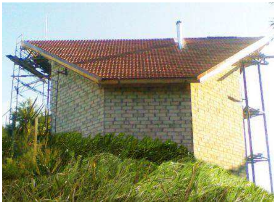
Рисунок 1.9 - Пример неостекленного глухого фасада с северной стороны (пассивный дом под Черниговом, архитектор Т.Эрнст)
