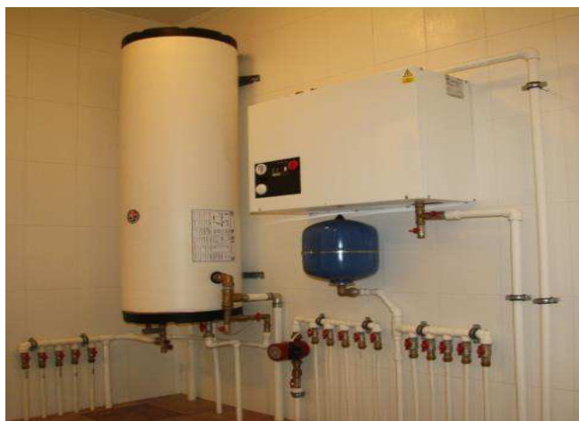
Рисунок 1.16 – Устройство системы электрического отопления
