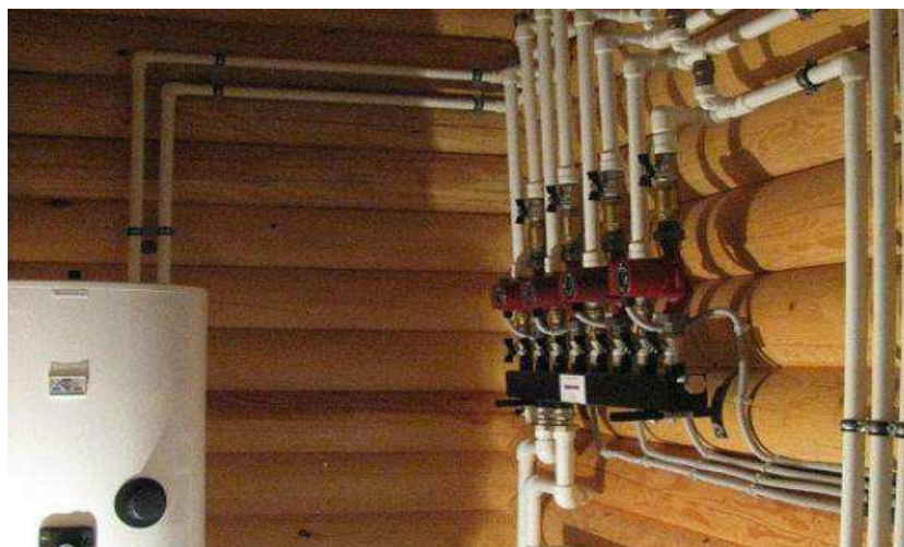
Рисунок 1.33 – Система отопления деревянного дома
