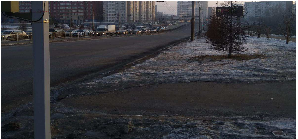
Рисунок 1.13 – Отсутствие дорожной разметки на пересечении ул. Краснодарская – ул. Воронова
