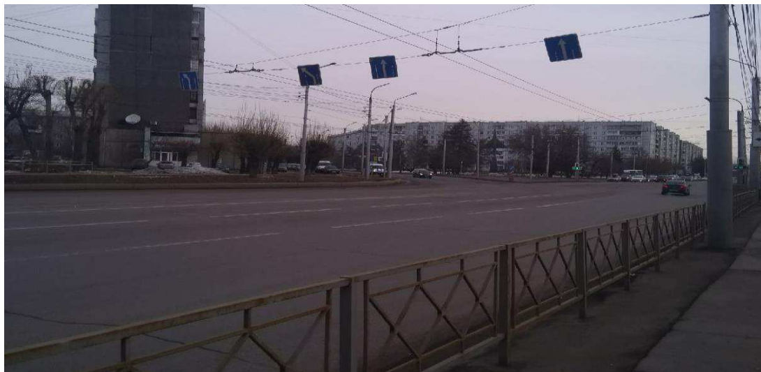
Рисунок 1.14 – Вид на физический износ и отсутствие дорожной разметки на пересечении пр. Metallургов – ул. Партизана Железняка – ул. Краснодарская
