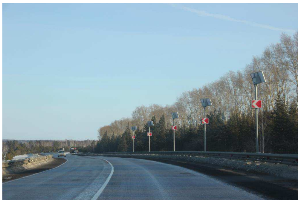
Рисунок 3.4 – Фотографии аварийно-опасного участка федеральной автомобильной дороги Р-255
