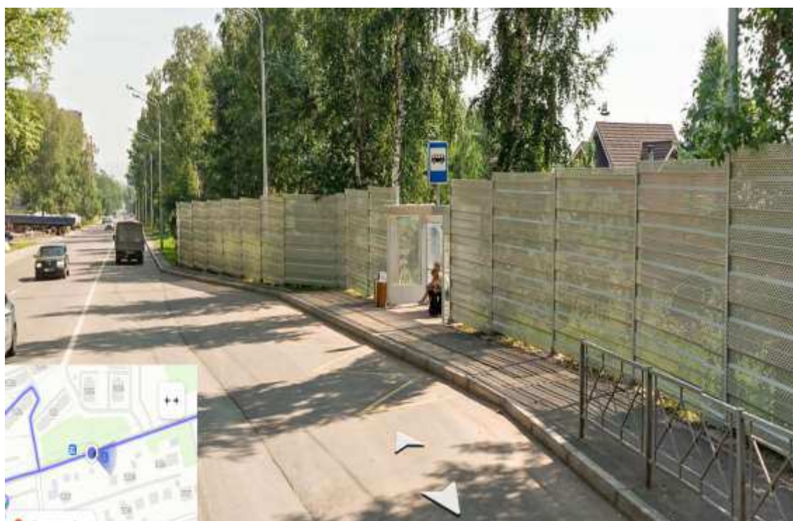
Рисунок Б1 - Остановочный пункт Березовая (в прямом направлении)
