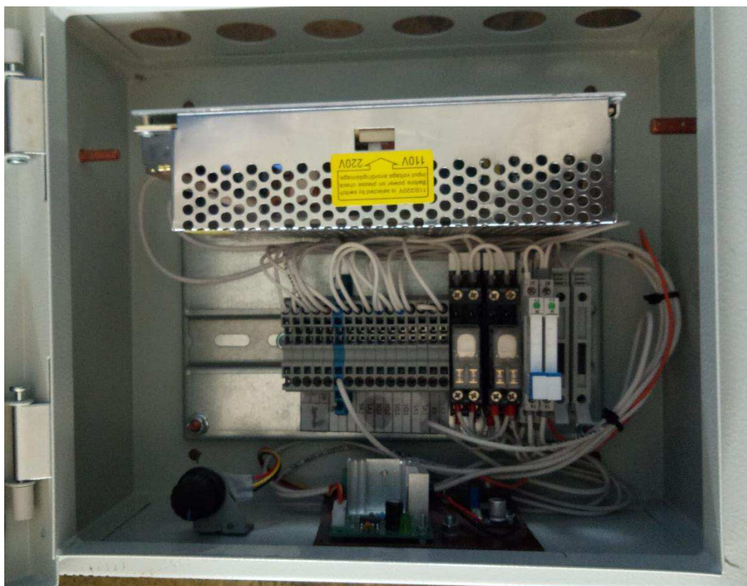
Рисунок 22 – Сборка электрического шкафа
