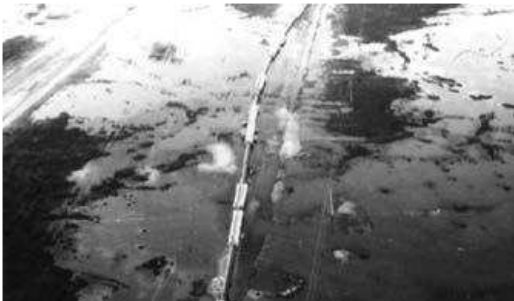
Рисунок 8 – Выпучивание подземного трубопровода (арочный выброс) [13]
