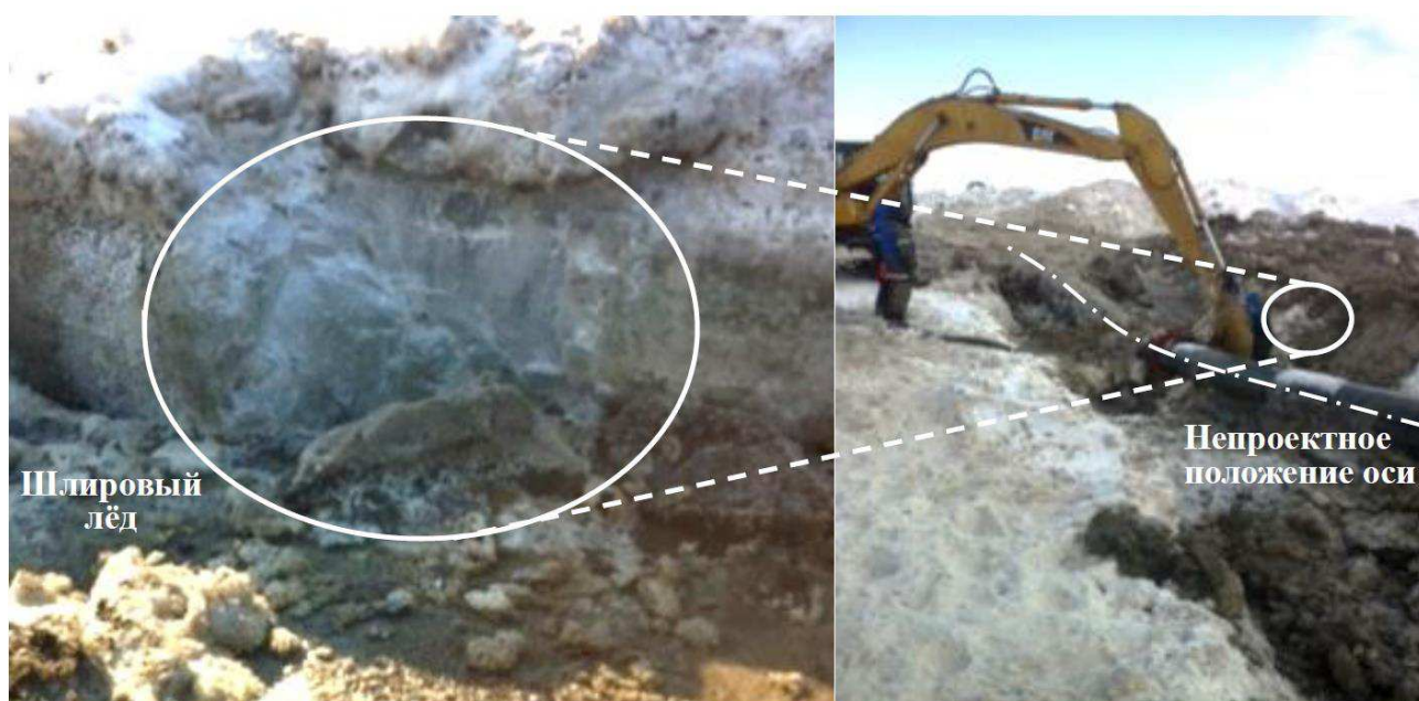
Рисунок 7 – Изменение проектного положения магистрального конденсатопровода диаметром 530 мм [1]
