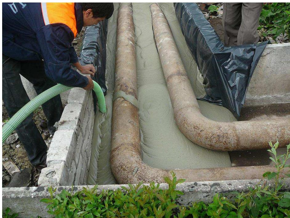
Рисунок 6 — Утепление трубопроводов монолитным пенобетоном
