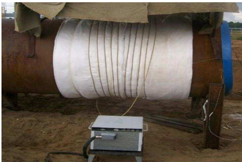
Рисунок 3– Индукционный подогрев стыка
