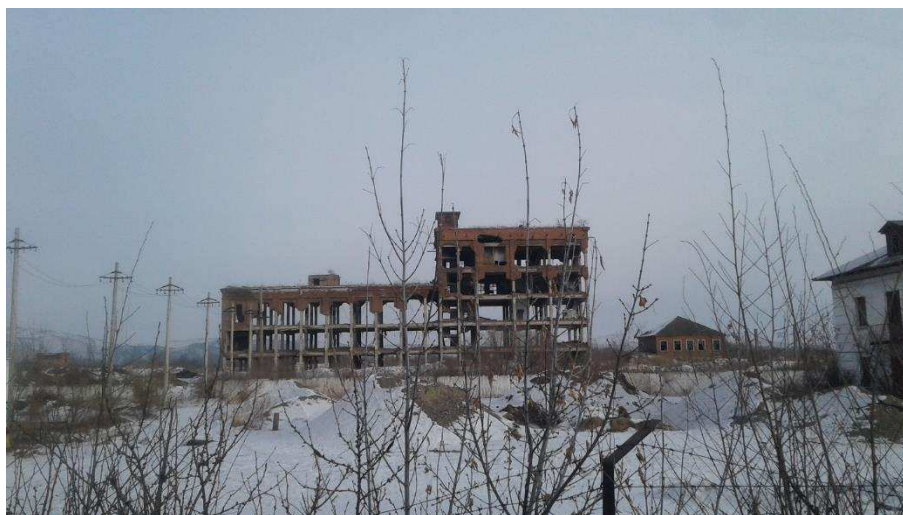
Рисунок 10 - Общий вид спиртового цеха гидролизного завода в п. Усть-Абакан в настоящее время
