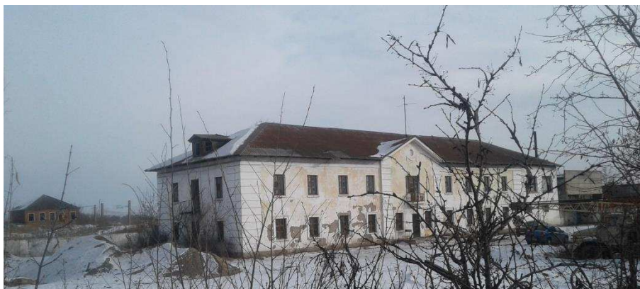
Рисунок 8 – Общий вид административного здания гидролизного завода в п. Усть-Абакан в настоящее время
